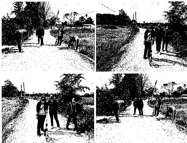
ตงลูกวิ่งซ่อมถนน จากบ้านนางวันเพ็ญ สะอาดเล็ก ถึง บ้านนางประเสริฐ เมื่อพระราชวัง หมู่ ๒
